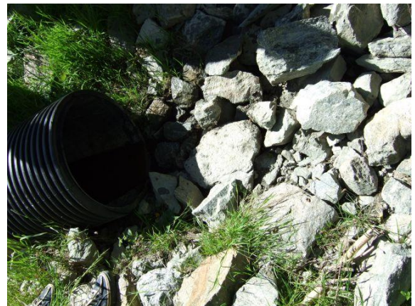
Erosjonssikring med stein rundt rørutløp
